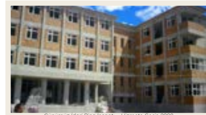
Günümüz İdari Bina İnşaatı - Hizmette Geçiş 2008
