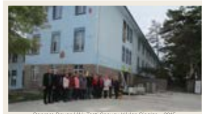
Deprem Dayanıklılık Testi Sonucu Yıkılan Binalar - 2015
