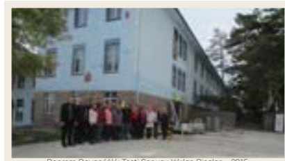
Deprem Dayanıklılık Testi Sonucu Yıkılan Binalar - 2015
