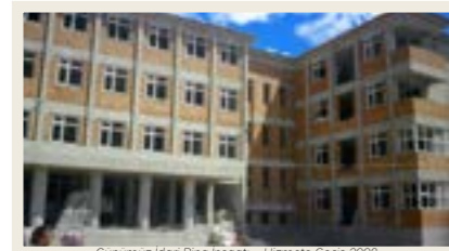
Günümüz İdari Bina İnşaatı - Hizmette Geçiş 2008
